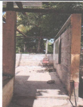
Foto 4: se ha sustituido la puerta de madera para colocar una de metal
