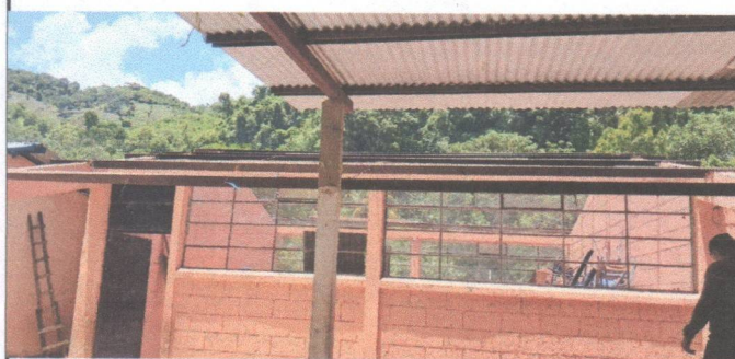
Foto 6: Se ha sustituido la cubierta de lámina (Modulos 1,2 y 3)
