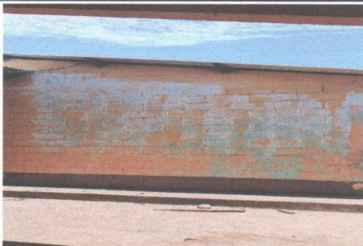
Foto 1: El trabajo de pintura de las paredes no se ha iniciado, porque se dejarán de último (Modulos 1,2 y 3).
