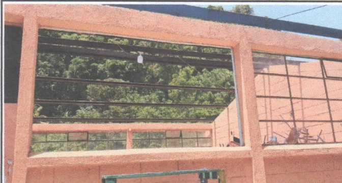
Foto 2: Se ha procedido a la sustitución de ventanas para colocar balcones, para mayor seguridad y ambiente (Modulos 1 y 2)
